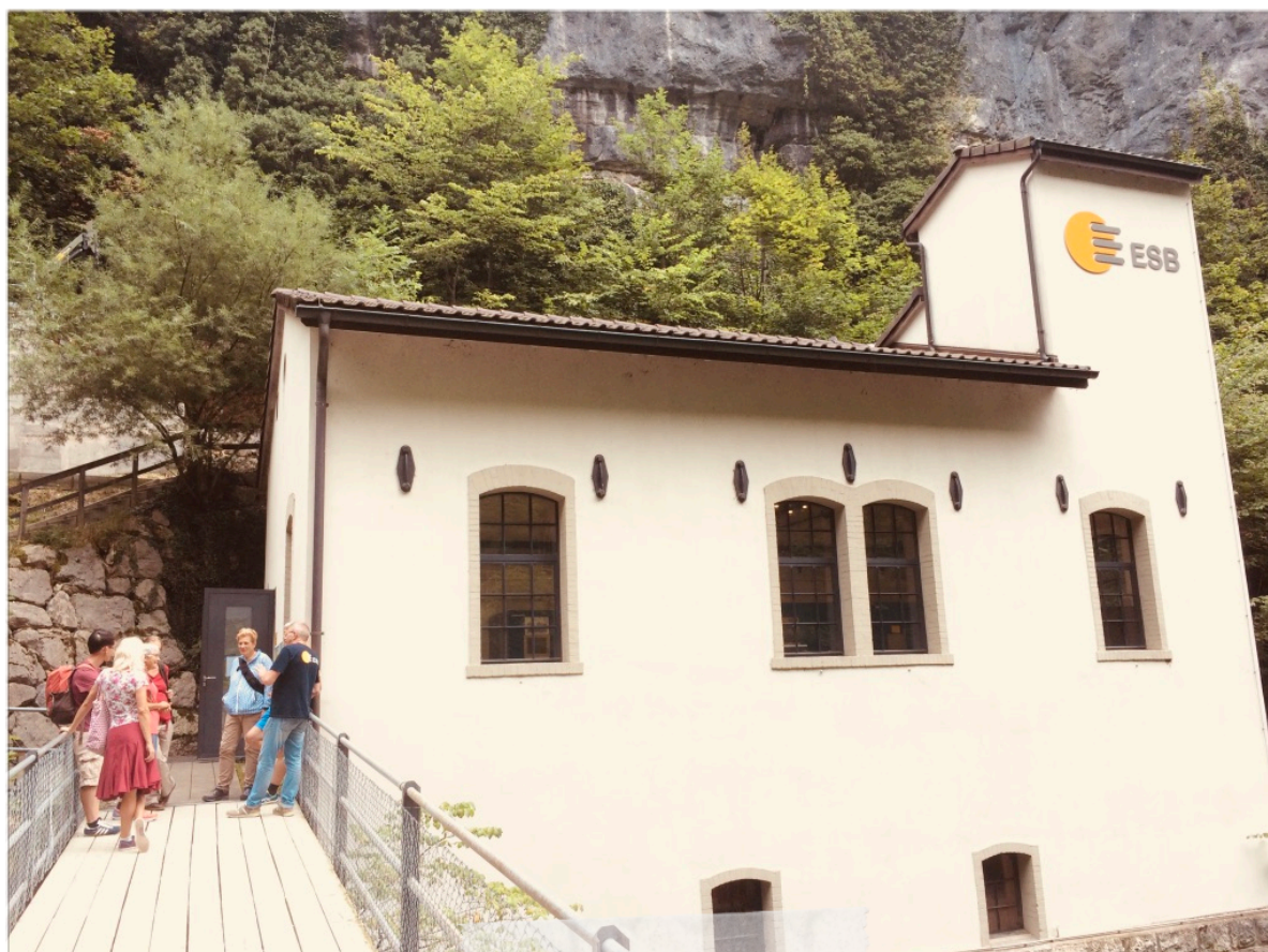
Visite de la centrale hydroélectrique du Taubenloch en août 2017 Besuch des Wasserkraftwerks Taubenloch im August 2017
